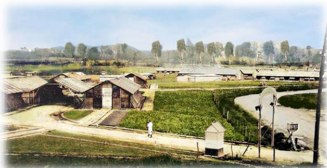
Entrée de l'Hôpital par la rue de la Gare
